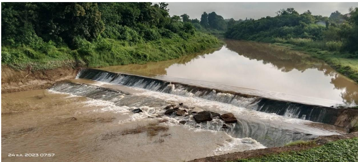
รูปที่ 4-9 ฝายแกนดินซีเมนต์แม่หลาย หมู่ 4 ต.แม่หลาย อ.เมืองแพร่ จ.แพร่ ที่มา : คณะกรรมาธิการการแก้ปัญหาความยากจนและลดความเหลื่อมล้ำ วุฒิสภา
