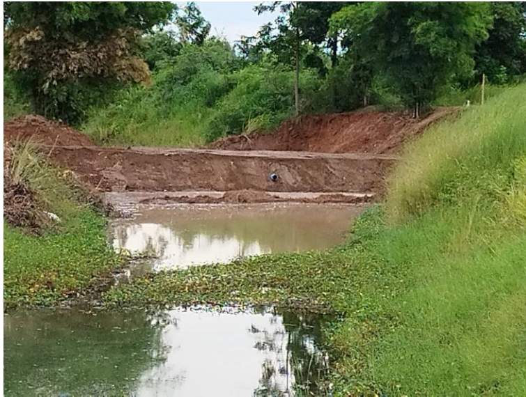
รูปที่ 4-8 ฝ่ายแกนดินซีเมนต์ห้วยยางฮาด ต.ทำนางแนว อ.แวงน้อย จ.ขอนแก่น
