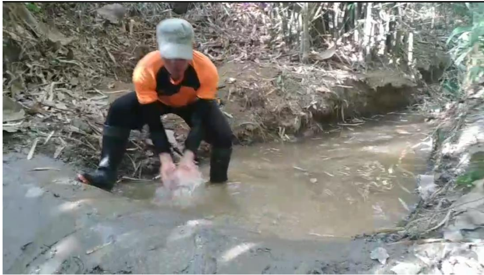
รูปที่ 4-14 ฝ่ายแแกนดินซีเมนต์ช่วยดินข้าง จ.น่าน
