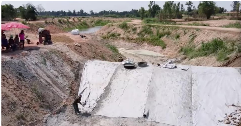
รูปที่ 4-10 งานก่อสร้างฝายแกนดินซีเมนต์ คลองห้วยทราย บ้านประชาร่วมใจ ม.16 ต.บ่อถ้ำ อ.ขามเฒ่า จ.กำแพงเพชร ที่มา : ศูนย์ปฏิบัติการบรรเทาภัยอันเกิดจากน้ำ 8 มี.ค. 2565
