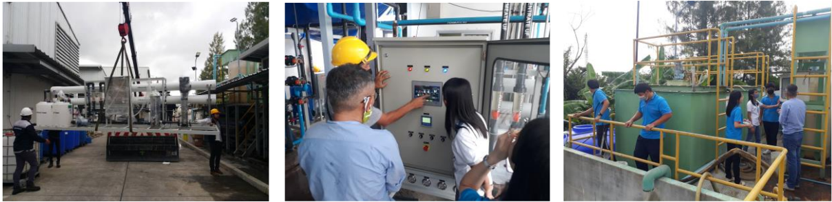
รูปที่ 3-64 การติดตั้ง RO membrane และทดสอบระบบของ บริษัท ไทยนิปอนรับเบอร์อินดัสตรี จำกัด (มหาชน)
