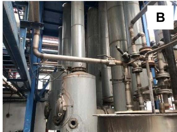
รูปที่ 3-109 ตำแหน่งติดตั้งมิเตอร์อัจฉริยะ A คือ ตำแหน่งน้ำขาเข้าโรงงาน B คือ ตำแหน่งท่อน้ำ Condensate ที่นำกลับมาใช้ของบริษัท ไทยซิลิเกตเคมีคัล จำกัด
