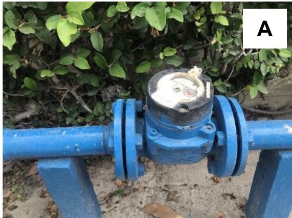
รูปที่ 3-109 ตำแหน่งติดตั้งมิเตอร์อัจฉริยะ A คือ ตำแหน่งน้ำขาเข้าโรงงาน B คือ ตำแหน่งท่อน้ำ Condensate ที่นำกลับมาใช้ของบริษัท ไทยซิลิเกตเคมีคัล จำกัด
