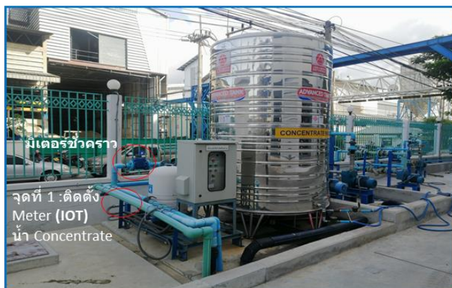
รูปที่ 3-32 ตำแหน่งติดตั้ง IoT ของบริษัท ไลอ้อน (ประเทศไทย) จำกัด
