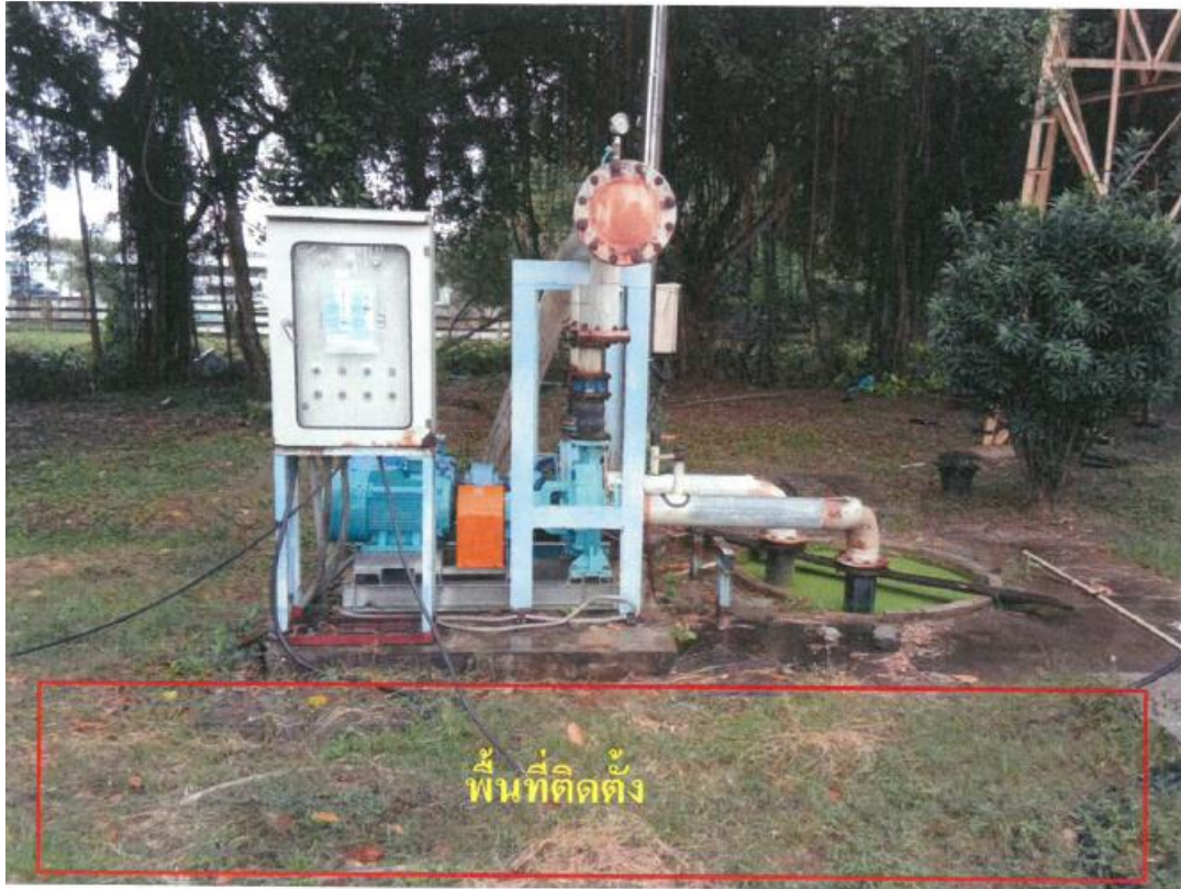
รูปที่ 3-37 ตำแหน่งติดตั้งระบบ Recycle น้ำทิ้งของบริษัท สหพัฒนาอินเตอร์โฮลดิ้ง จำกัด (มหาชน)
