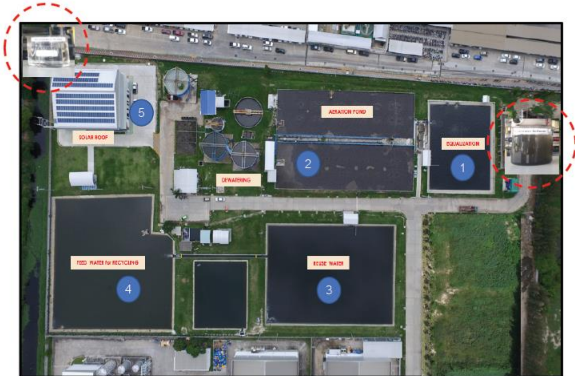
รูปที่ 3-2 โรงบำบัดน้ำเสียของนิคมอุตสาหกรรมอมตะซิตี้ ชลบุรี (ระบบบำบัดน้ำเสียแบบชีวภาพ)
