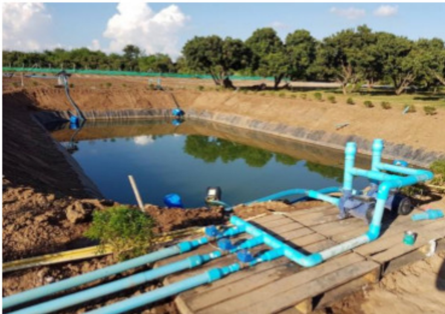
รูปที่ 3.1-5 การเดินท่อส่งน้ำจากบ่อเก็บเข้าสู่ระบบปั๊มอัตโนมัติ
