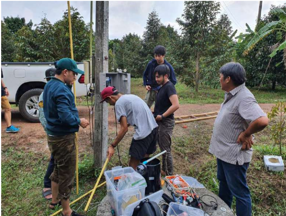
รูปที่ 3-3 การติดตั้งสถานีตรวจวัดข้อมูลสภาพภูมิอากาศ
