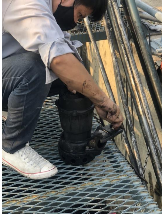
ภาพที่ 3.2.1-3 การปรับแก้ชุดตีนเป็ดเป็น Guide Rail
