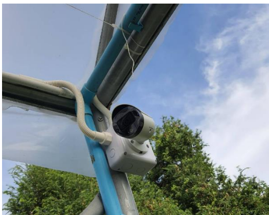
ภาพที่ 2.1.2-1 การติดตั้งกล้องวงจรปิด
