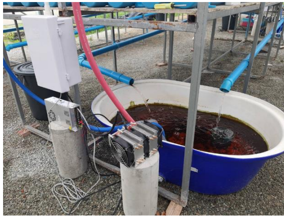
ภาพที่ 2.1.3-1 ระบบระบายความเย็นแบบเพลเทียร์
