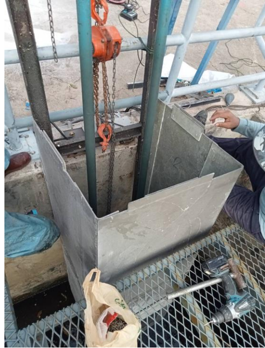
ภาพที่ 3.2.1-4 การติดตั้งตะแกรงกรองขยะเพิ่มขึ้นหลังตะแกรงของสถานีสูบน้ำเสีย
