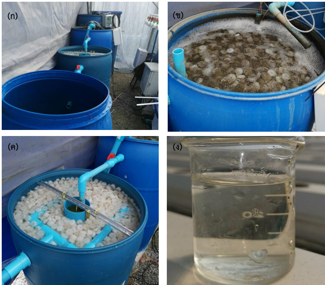
ภาพที่ 3.2.1-6 ระบบบำบัดน้ำเสียขนาดเล็กแบบ MBBR ณ โรงเรียนสาธิต “พิบูลบำเพ็ญ” มหาวิทยาลัยบูรพา
