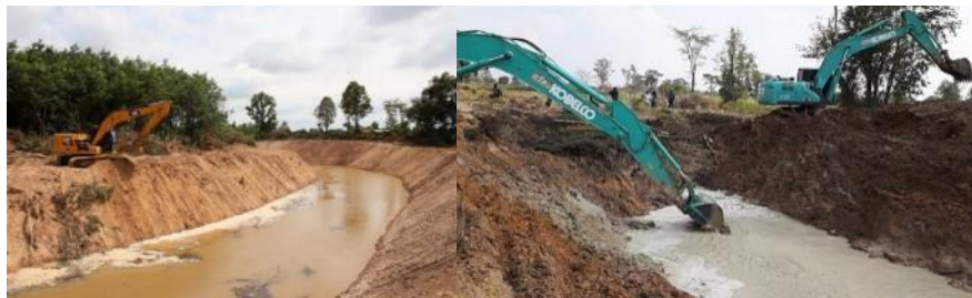
รูปที่ 4.7.2-1 ตัวอย่างการก่อสร้างทางผ่านน้ำหรือชุดคลองสายใหม่เชื่อมต่อกับแม่น้ำพื้นที่ที่มีปัญหาน้ำท่วม
