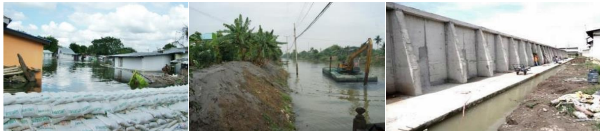
รูปที่ 4.7.2-2 ตัวอย่างการจัดทำคันกันน้ำเพื่อไม่ให้น้ำไหลลงตลิ่งเข้าไปท่วมพื้นที่ชุมชน
