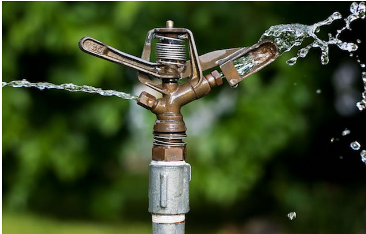
รูปที่ 3.2-1 ระบบสปริงเกอร์แบบ 360 องศา ที่ใช้อยู่ในสวนฯ 100 ปี
