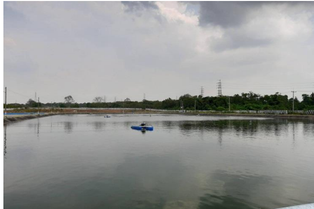
รูปที่ 2.76 บ่อเติมอากาศ
