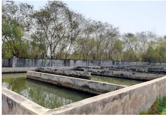
รูปที่ 2.11 บ่อพักน้ำหลังการบำบัดน้ำเสีย
