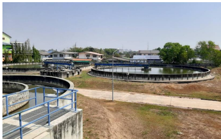
รูปที่ 2.10 บ่อดกตะกอน
