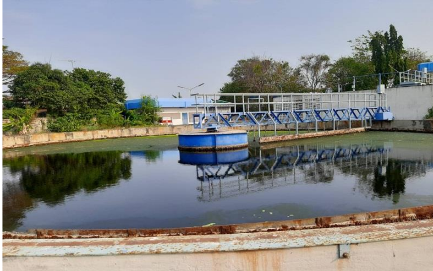
รูปที่ 2.60 บ่อดกตะกอน
