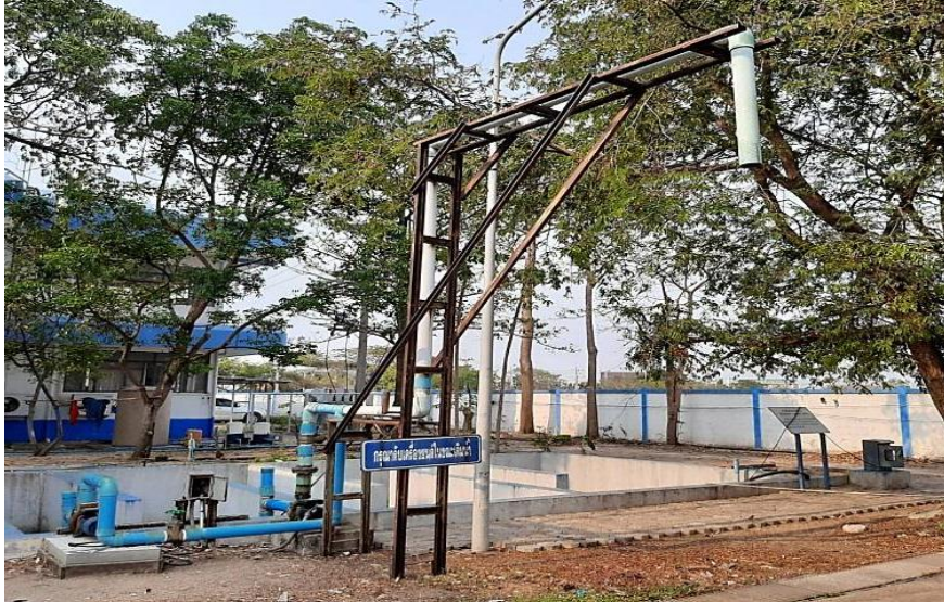
รูปที่ 2.55 จุดเติมน้ำที่ผ่านการบำบัดแล้วเพื่อการนำกลับไปใช้ใหม่
