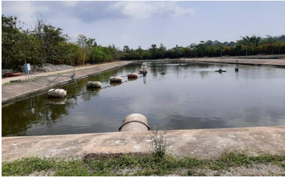
รูปที่ 2.38 บ่อเติมอากาศ
