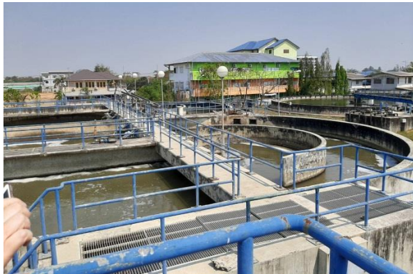
รูปที่ 2.9 บ่อเติมอากาศแบบคลองวนเวียน
