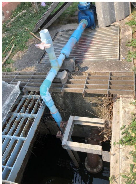
รูปที่ 2.45 แนวท่อสูบน้ำเพื่อนำน้ำกลับมาใช้ใหม่
