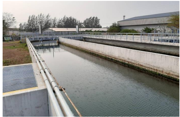
รูปที่ 2.61 บ่อเติมอากาศแบบคลองวนเวียน
