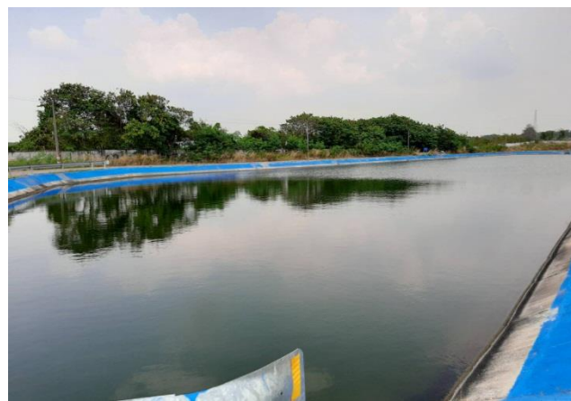
รูปที่ 2.77 บ่อตกตะกอน
