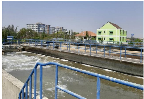
รูปที่ 2.9 บ่อเติมอากาศแบบคลองวนเวียน
