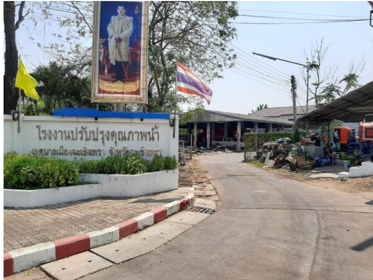
รูปที่ 2.6 ด้านหน้าโรงบำบัดน้ำเสีย
