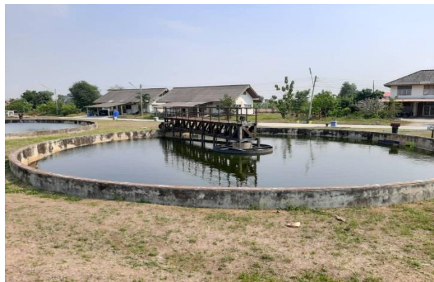
รูปที่ 2.20 บ่อตกตะกอน
