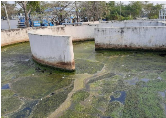
รูปที่ 2.61 บ่อเติมอากาศแบบคลองวนเวียน
