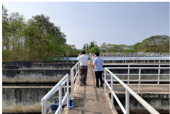
รูปที่ 2.85 บ่อเติมอากาศแบบคลองวงเวียน
