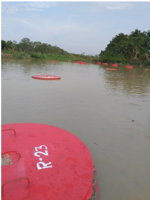
รูปที่ 8-3 ตัวอย่างการเติมน้ำใต้ดินระดับตื้นโดยใช้บ่อวงเติมน้ำ (กรมทรัพยากรน้ำบาดาล, 2563)
