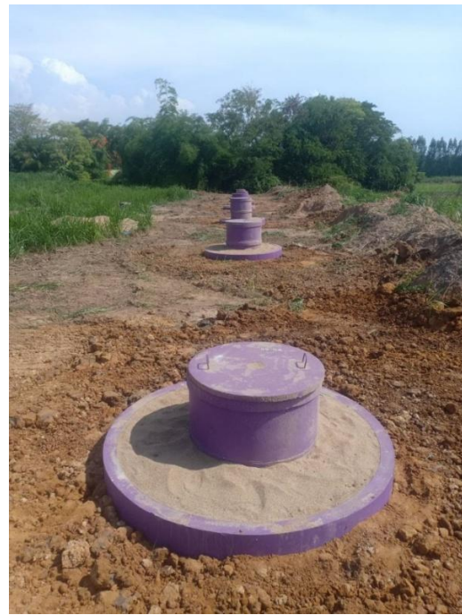
รูปที่ 8-3 ตัวอย่างการเติมน้ำใต้ดินระดับตื้นโดยใช้บ่อวงเติมน้ำ (กรมทรัพยากรน้ำบาดาล, 2563)
