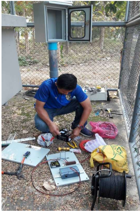
ภาพที่ 3 การเตรียม Board ส่งสัญญาณข้อมูลเพื่อไปเก็บบน cloud และ server
