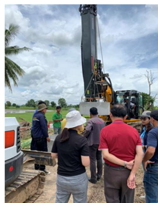
ดูพื้นที่การขุดบ่อเติมน้ำใต้ดิน อ.บางระกำ จ.พิษณุโลก
