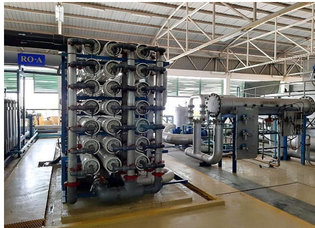
รูปที่ 2.3 ระบบออสโมซิสผันกลับ (Reverse Osmosis)
