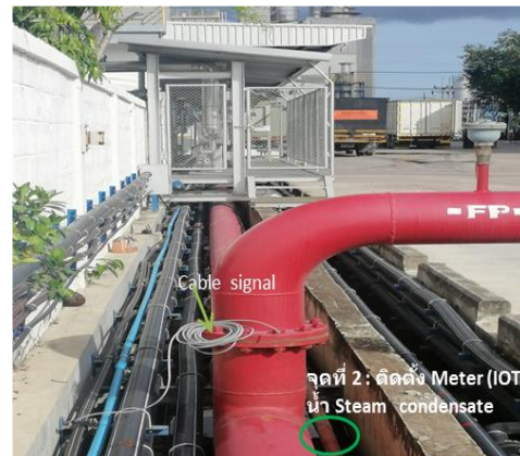
รูปที่ 4.72 ตำแหน่งการติดตั้ง มิเตอร์ IoT ของบริษัท ไลอ้อน (ประเทศไทย) จำกัด ภายใต้การดำเนินโครงการ
