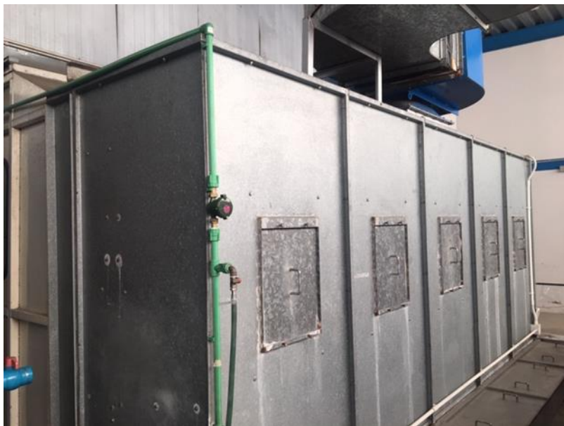
รูปที่ 4.65 ตำแหน่งติดตั้ง meter น้ำห้องฟอสส์ ของบริษัท ไทยคิวบิคเทคโนโลยี จำกัด ภายใต้การดำเนินโครงการ
