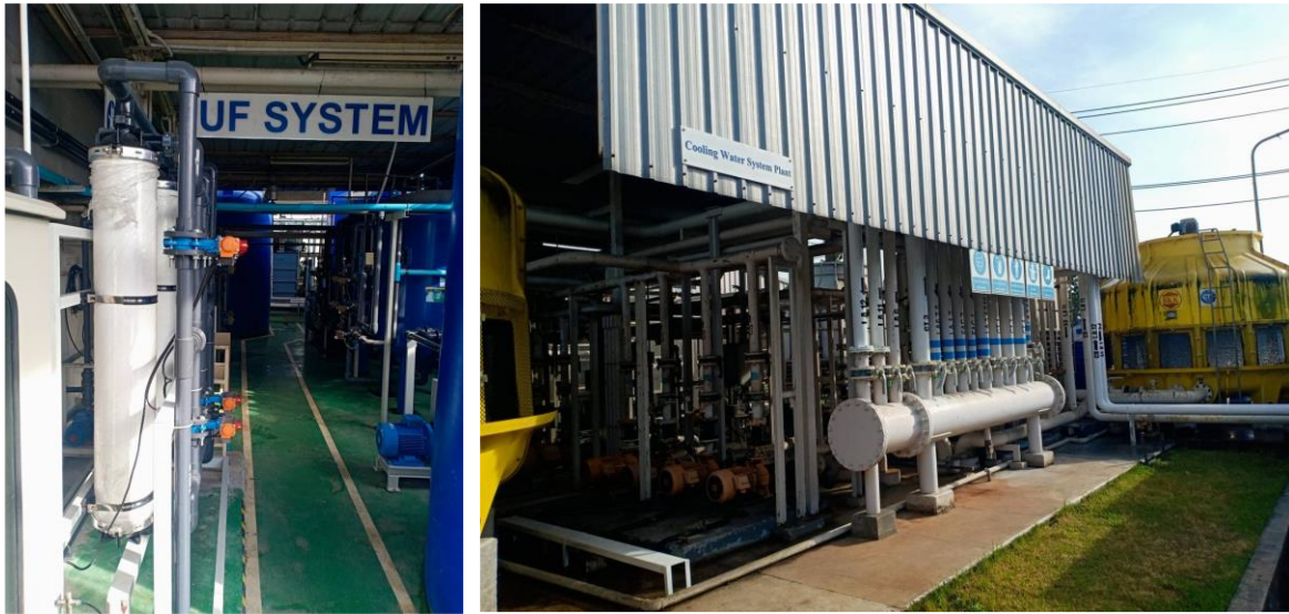
รูปที่ 4.10 ระบบการ recycle น้ำของบริษัท ไตกิ้น คอมเพรสเซอร์ อินดัสทรีส์ จำกัด
