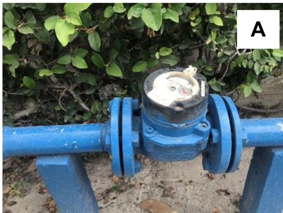
รูปที่ 4.56 ตัวอย่างการติดตั้งมิเตอร์ของบริษัท ไทยซิลิเกตเคมีคัล จำกัด โดย A คือ ตำแหน่งน้ำขาเข้าโรงงาน B คือ ตำแหน่งท่อน้ำ Condensate ที่นำกลับมาใช้
