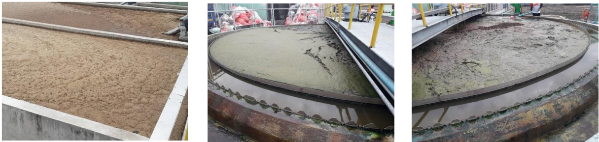
รูปที่ 4.47 ลักษณะตะกอนในระบบบำบัดของบริษัท ไทยเพรซิเดนท์ฟูดส์ จำกัด (มหาชน) ก่อนการดำเนินโครงการ
