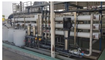
ปรับปรุงระบบ Recycle น้ำ
