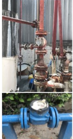
สำรวจอุปกรณ์เดิม ภายในโรงงาน
