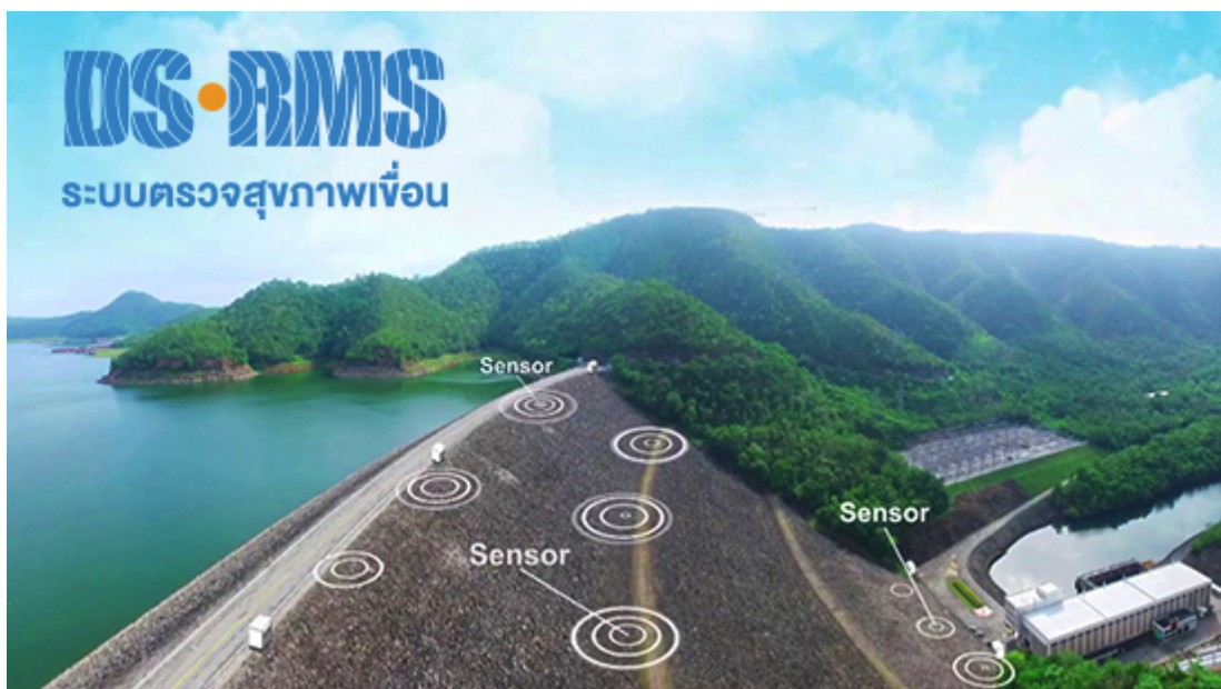
รูปที่ 7-32 ระบบตรวจสอบสุขภาพเขื่อน หรือ DS-RMS (Dam Safety Remote Monitoring System) ที่มา: https://www.nectec.or.th/innovation/innovation-software/dsrms.html
