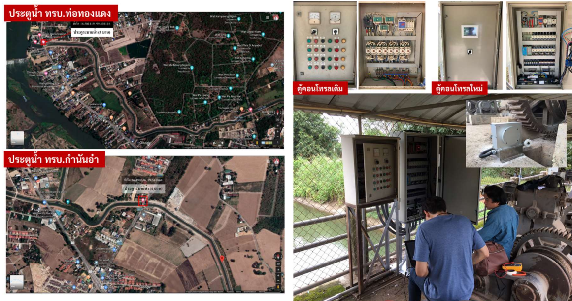
รูปภาพ ผลการติดตั้ง Automatic Gate ทรบ.ปากคลอง MC กม.0+115 และ ทรบ.กลางคลอง MC กม.5+870 (ทรบ.กำนันอ่ำ)
